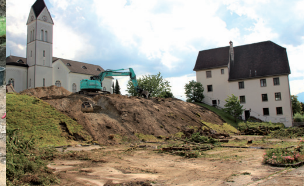
Hier entsteht das neue Gebäude der Kinderbetreuung
